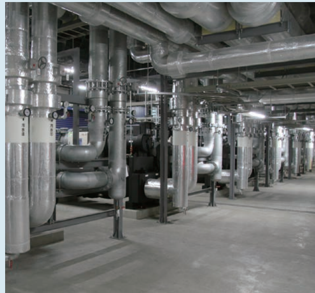
▲ インバーター式ターボ冷凍機が並ぶ
