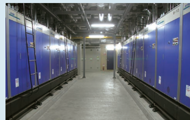
▲温水ボイラー
